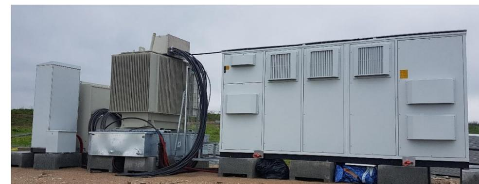
Photographie 66. Exemple d'onduleurs et transformateur installés à l'extérieur
